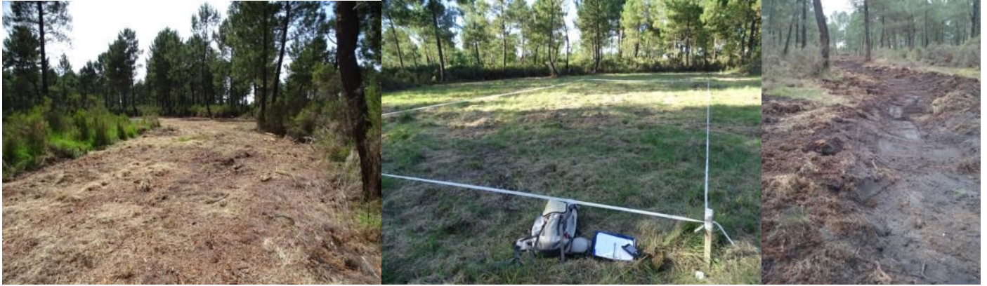
De GàD : Débroussaillage de 4 m de large ; repérage de l'emprise de la mare pour l'expertise pyrotechnique ; réalisation de la cunette. (photos ONF G.Granereau et UT de Roquefort)
