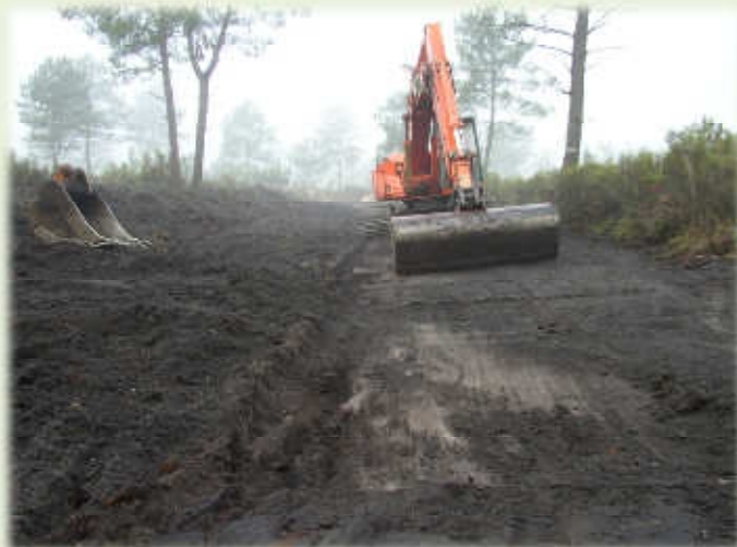
Finition de la cunette.
