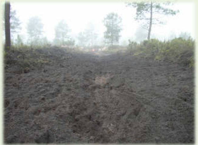
De là, une cunette très large a été ouverte pour drainer les eaux vers la mare. On distingue à gauche un andain formé par les déblais.
