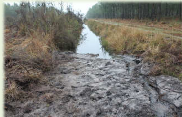
Le bouchon le plus en amont subit un débordement : une petite rigole se forme. Elle devrait prendre plus d'ampleur (à confirmer).
