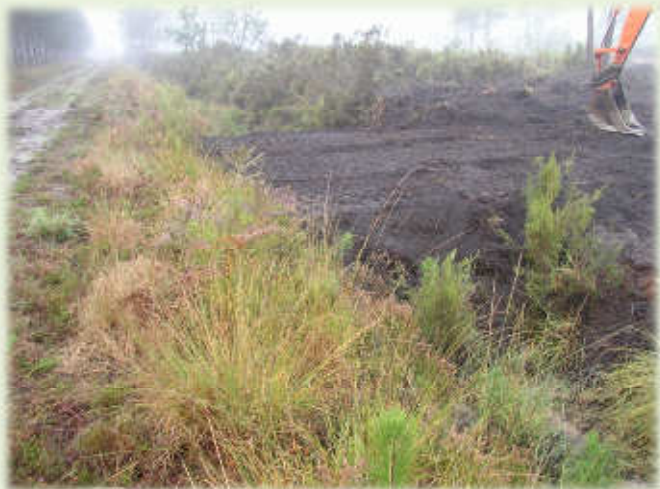
Le bouchon a été placé à 20 cm en-dessous du niveau du chemin (à gauche).
