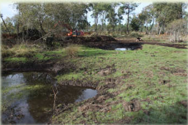
Vue prise depuis la zone en eau existante (L1), qui a été préservée (présence de batraciens, d'Eleocharis, de potamo...). Au fond, la nouvelle zone-refuge.
