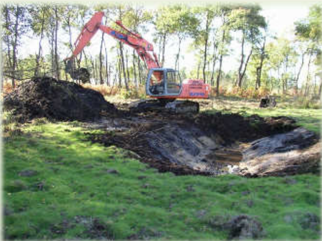
Une zone refuge (L2) a été ouverte, afin d'avoir de l'eau en permanence. Sur cette bordure sud, l'épaisseur de la tourbe était de 0,6 à 0,7 m. Les déblais seront ensuite déplacés et mis en tas plus au sud.
