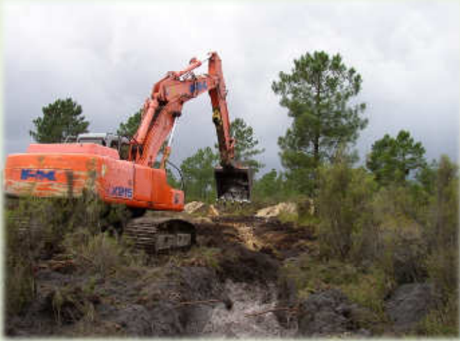
La pelle mécanique en train de tracer le fond de la cunette ; on voit les déblais de la mare en arrière-plan.
