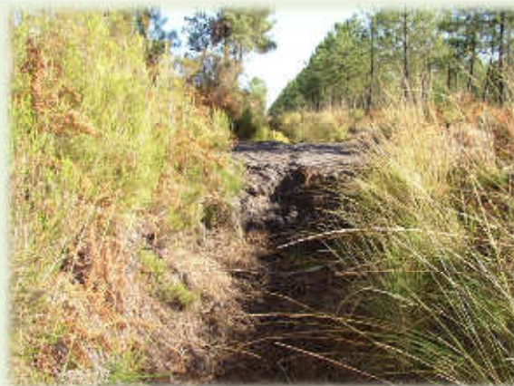
Un des bouchons mis en place. Le chemin est à droite, plus haut de 50 cm par rapport au seuil.
