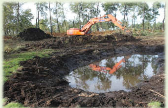
Le lendemain, la zone refuge est déjà en eau ; les déblais sont remis en tas plus au sud.
