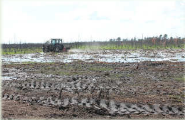
Les conditions météo ont rendu délicate cette opération, la pluviosité ayant été forte, sans oublier la remontée naturelle de la nappe favorisée par l'enlèvement de la végétation.
