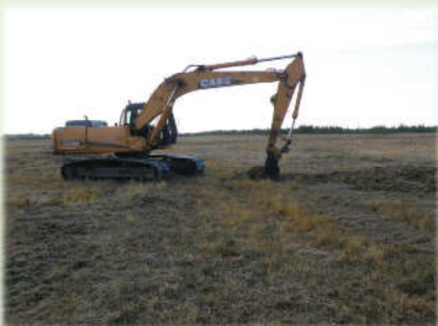
Une opération de broyage avec exportation a été testée, avec une pelle mécanique. Les résultats ont été satisfaisants, et les coûts moindres que ceux proposés actuellement avec un engin autonome.
