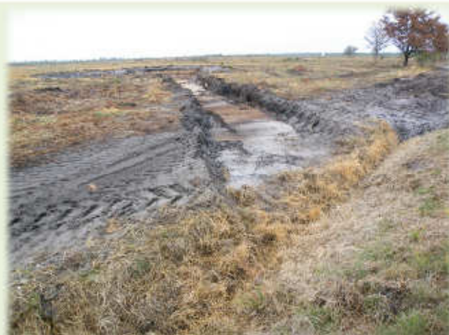
Premier test de « cunette » ou fossé rigolé. On voit le bouchon à droite qui permet d'envoyer les eaux vers la mare via la cunette. Ici, mare rue 2.
