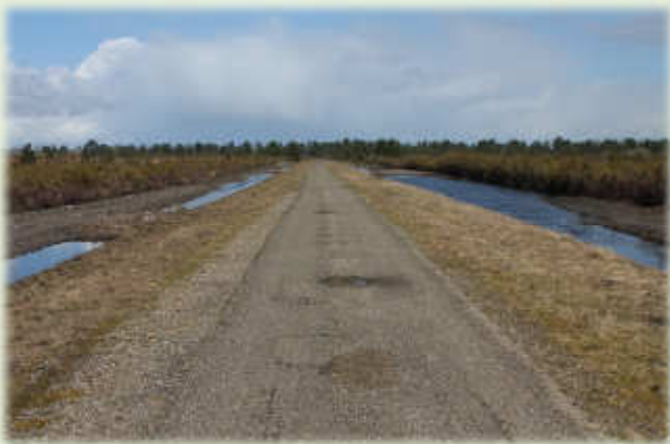
L'eau retenue de part et d'autre de la route ... sans risque de l'inonder.
