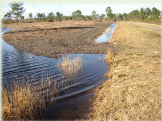
Bouchon destiné à renvoyer l'eau vers la mare. En aval, l'eau que l'on voit dans le fossé est celle du niveau de la nappe. En l'absence de bouchons, elle se vidait dans le canal. Elle est donc aujourd'hui mieux contenue.
