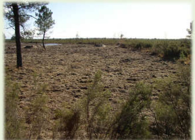
Vue prise depuis le nord du chantier, où l'on voit la zone broyée en 2012 (à gauche), et à droite celle qui sera traitée fin 2013..
