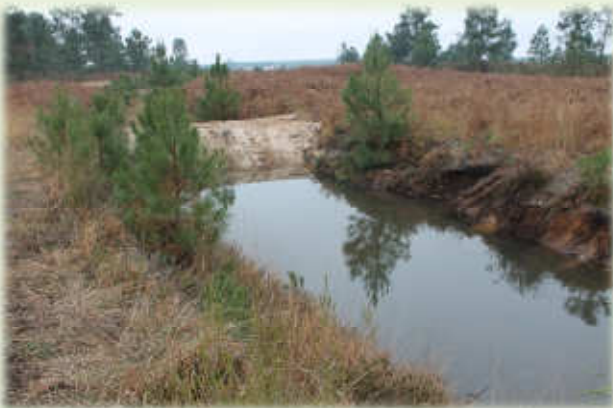
Du sable a été placé sur certains seuils constitués de billes de pins, afin de les étanchéifier. Le résultat est apparu rapidement.
