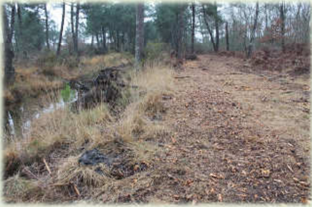
Janvier 2014 : Profitant de ces travaux, un broyage a été fait côté nord du canal afin d'ouvrir ce secteur qui était jusque-là très fermé.
