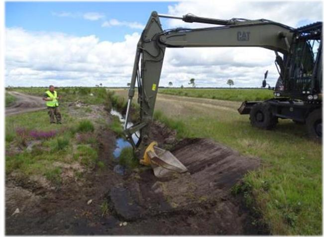
Fossé détourné par le biais d'une cunette (à gauche). On voit le seuil « bouchon » (centre), l'eau en aval ne circule pas, contenue par des seuils : il s'agit donc du niveau de nappe. A droite, mise au point avec le Génie d'un profil de fossé « cunette »
