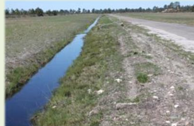
Exemple de fossé bordier ; en bas, avec mise en place de seuils : l'eau est retenue, mais n'inonde pas la rue !
