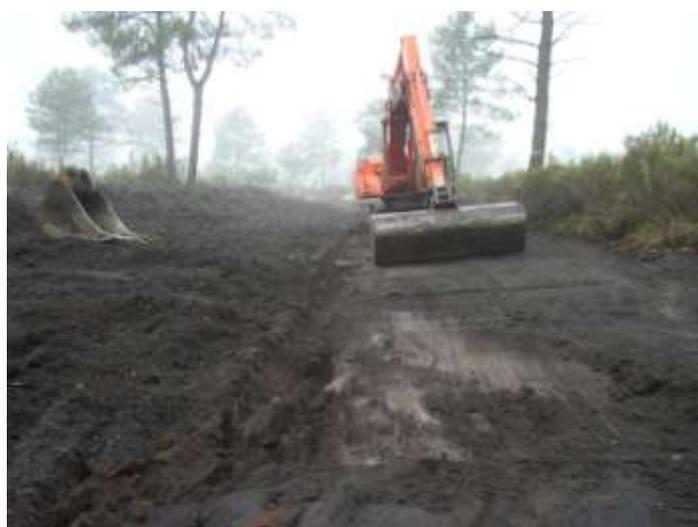
Octobre 2013 : nivellement d'un fossé cunette « pare-feu » (10 m de large), d'une profondeur de 40 cm. Les déblais sont placés sous la pente (ici, à gauche). Là encore, le risque d'érosion est limité, et de plus, ce type de fossé, assez large, peut avoir une utilisation en matière de pare-feu, voire d'accessibilité à l'intérieur de parcelles boisées.
