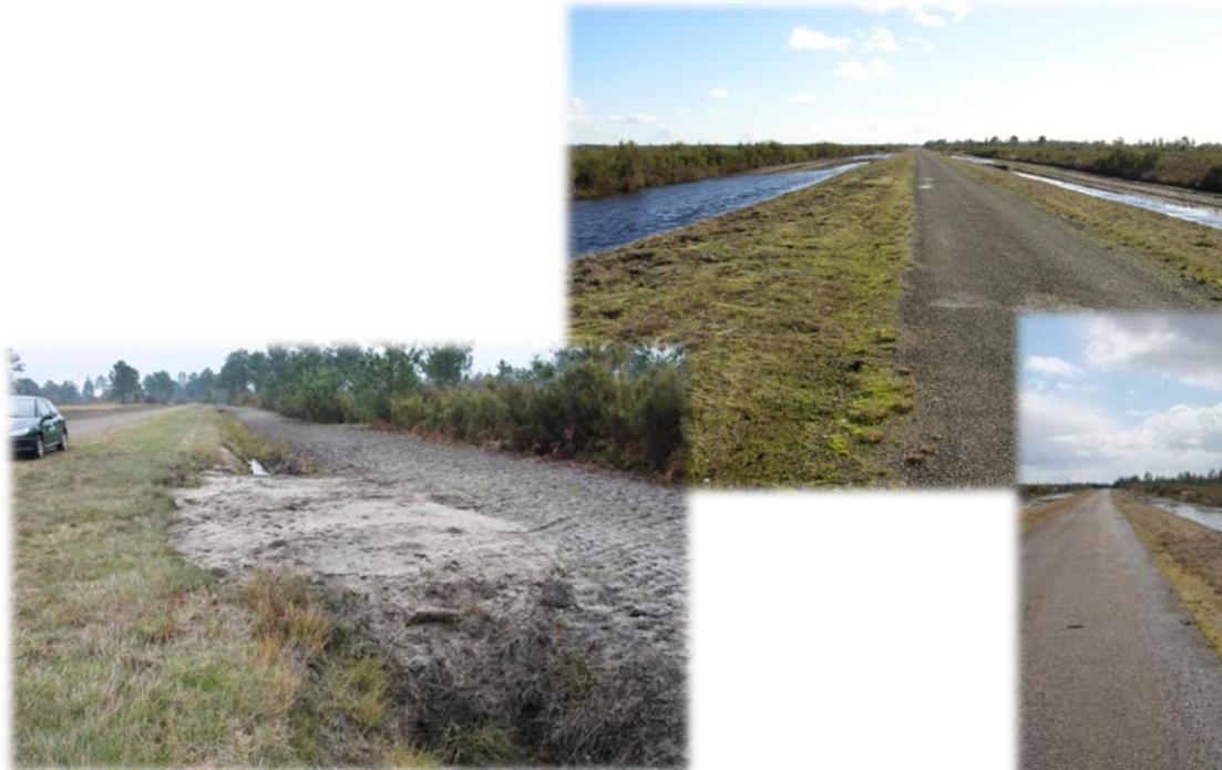
Billes de pins (expérimentation) ; bouchon de sable ; résultat en hiver ; le surplus d'eau s'écoule en ruissellement naturel, sans provoquer d'érosion.
