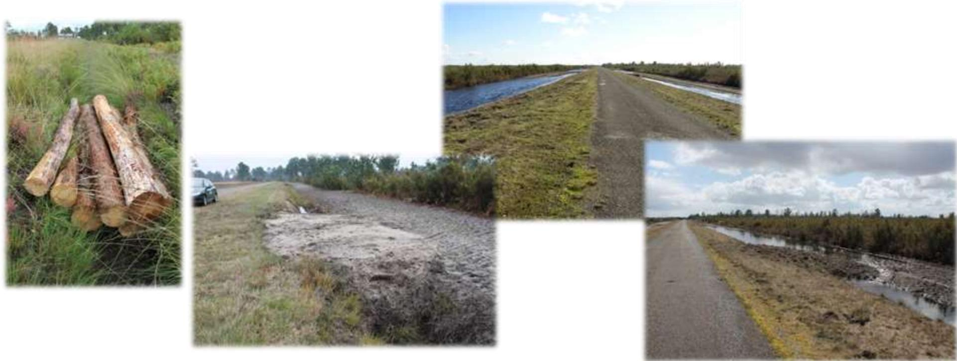
Billes de pins (expérimentation) ; bouchon de sable ; résultat en hiver ; le surplus d'eau s'écoule en ruissellement naturel, sans provoquer d'érosion.
