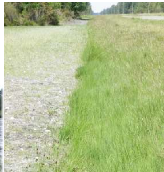
On obtient finalement une cunette, franchissable (pas de passages busés nécessaires) et facile à entretenir.
