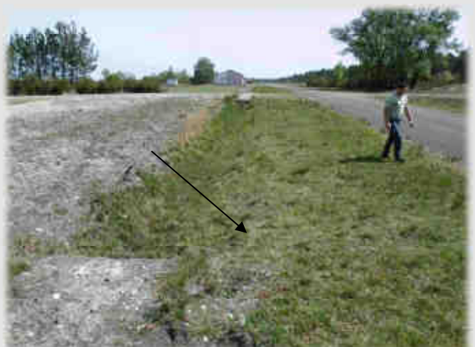
La station se trouve près du passage busé, en bordure du fossé : les pieds sont au moins à 2 m de la chaussée.
