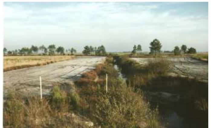
Photo n° 16 : (16-11-1988). Le Peyronnet vu du même point que la photographie n°15, après recreusement et reprofilage du cours d'eau aux environs des années 1979-80. L'accélération importante du débit a provoqué érosion des berges, surcreusement du lit et affaissement du pont ; la baisse du niveau de la nappe phréatique s'est traduite par la régression très nette de la Molinie et la colonisation par la Brande, la Callune et la Bruyère cendrée. Une végétation ligneuse et herbacée s'est développée sur les rives du cours d'eau.
