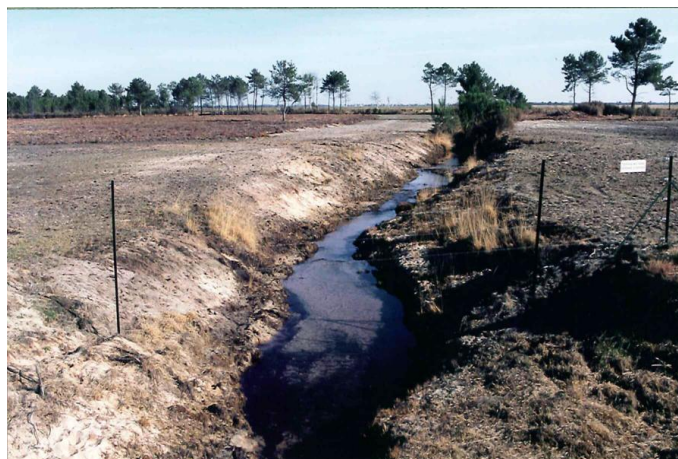
Photo 4 : en janvier 2002, même angle de prise de vue que la précédente après recreusement du lit du Peyronnet, suppression du radier sous le pont et divers travaux d'aménagement exécutés vers 1983-84. L'érosion régressive se manifeste jusqu'au centre du camp. L'abaissement de la nappe phréatique supérieure se situe entre 1,2 m et 1,5 m. (Callen, 28 janvier 2002.)
