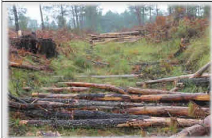
Amont du point 23 : Exemples de seuils « poreux », dont l'objectif sera de former progressivement des bouchons. Et de remonter le fond du lit. Ce système devrait permettre de favoriser les peuplements de Faux-cresson de Thore. A partir d'ici, on commence à trouver de la Molinie dans le fond, ce qui marque la présence sporadique de l'eau.
