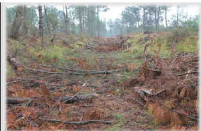
Point 23 : au niveau du gué de la rue 4, le fossé partant vers le nord a été bouché (houppiers + billes), et également les fossés arrivant de la rue 4. Le canal devient ici un peu plus large (6 m, avec des berges végétalisées, où seuls quelques pins (et feuillus) ont été gardés, fond à 1,2 m.
