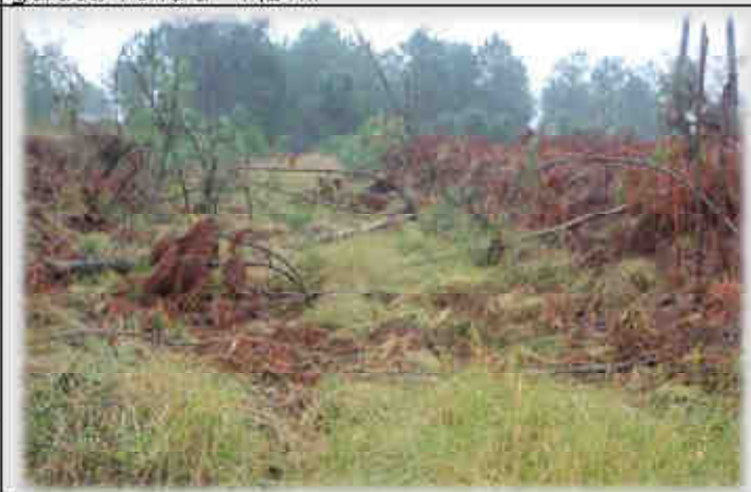
Point 23 : au niveau du gué de la rue 4, le fossé partant vers le nord a été bouché (houppiers + billes), et également les fossés arrivant de la rue 4. Le canal devient ici un peu plus large (6 m, avec des berges végétalisées, où seuls quelques pins (et feuillus) ont été gardés, fond à 1,2 m.
