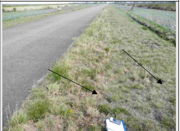
Vue de la station de quelques m2 rue 16.
